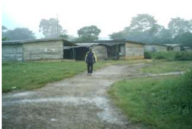
Photo 1 : Camp ouvrier dans la division 2 de Badjob
